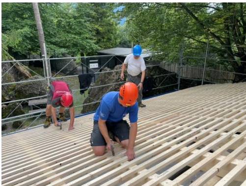
oder bei der Montage der Dachlatten.
