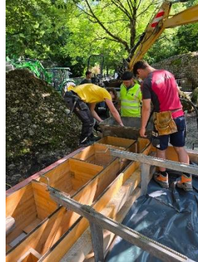
... bei der Erstellung des Fundaments
