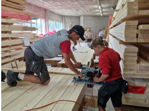
Viel Einsatz bewiesen die Auszubildenden bei ihren Tätigkeiten für den neuen Rastplatz Luchs: ob beim Zuschneiden des Holzes,
